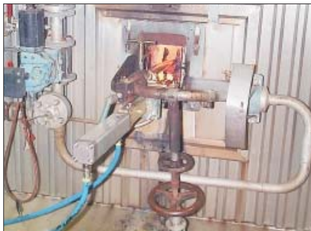
Монтаж SPRAYROD для очистки брызгозащитной плиты на распылителе щелочи.
