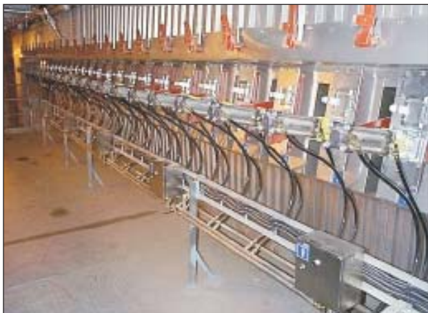
Монтаж трубоочистного робота Diamond на первичном уровне воздуха.
