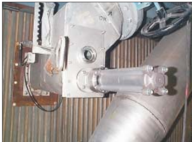
Монтаж газонепроницаемого очистителя канала для DNCG трубоочистного робота Diamond GT.
